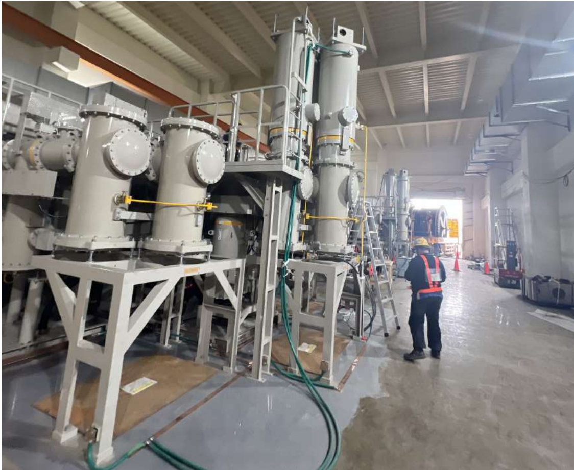
設備進場與電纜支架及設備拉線工程
