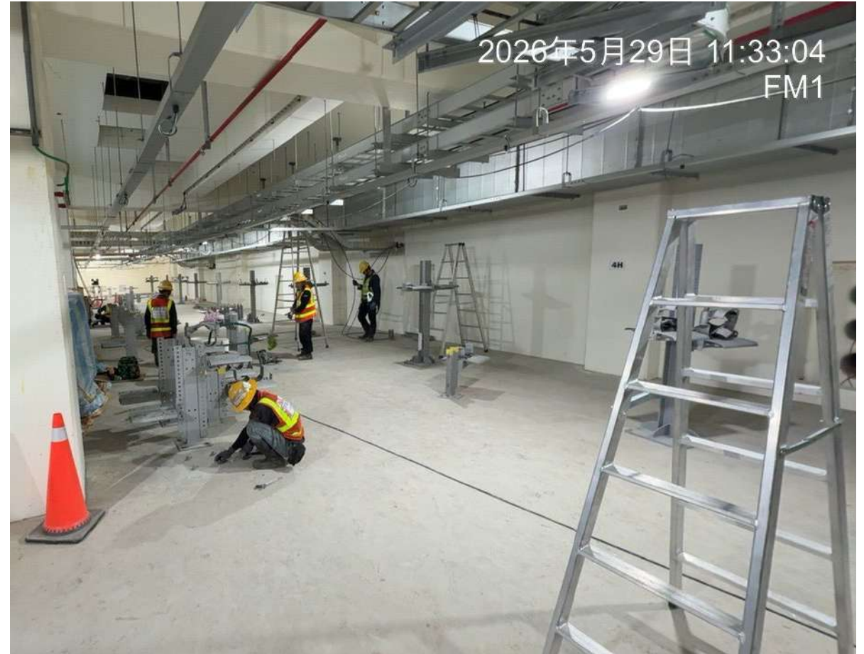
設備進場與電纜支架及設備拉線工程
